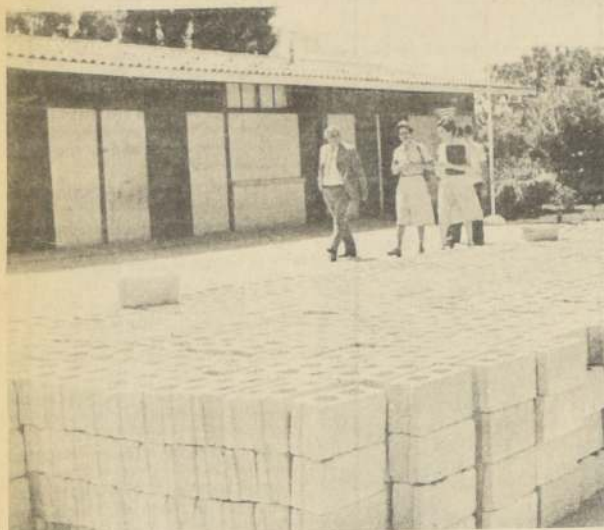
La Escuela D-437 de El Retiro, en Quilpué, no presentará deficiencias al iniciarse el próximo mes el nuevo período de enseñanza. El Alcalde, Guido Olguín, acompañado de funcionarios de la Dirección de Educación de la Municipalidad, inspeccionó los trabajos y el acopio de materiales.
