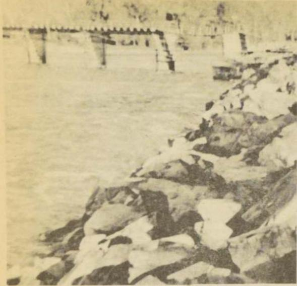
EL ESPIGON DE ENROCADOS impedirá una nueva destrucción del puente sobre el río Michimahuida.
