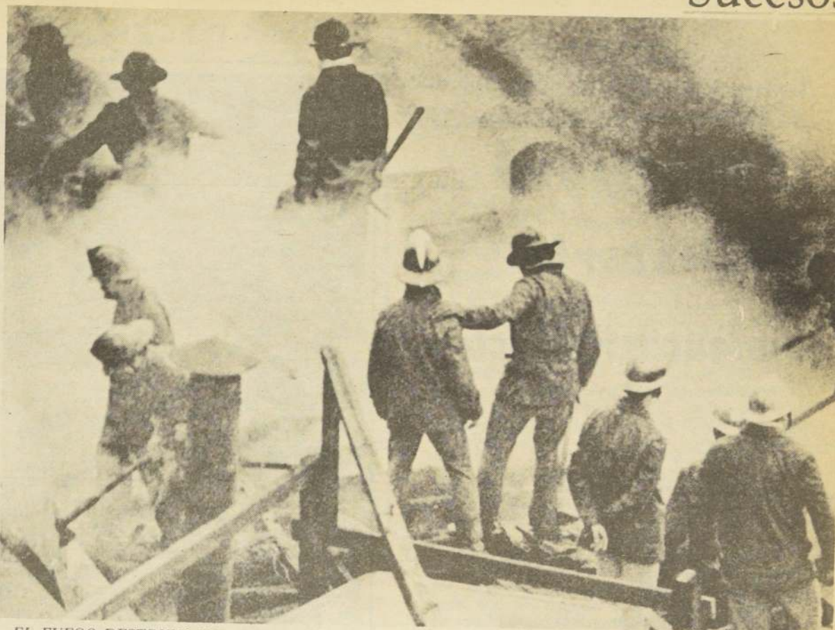
EL FUEGO DESTRUYO 74 módulos comerciales y el restaurante de la Zona Franca de Punta Arenas. Acudieron todas las compañías bomberiles de la ciudad y se demolieron algunas murallas en peligro de derrumbarse.
