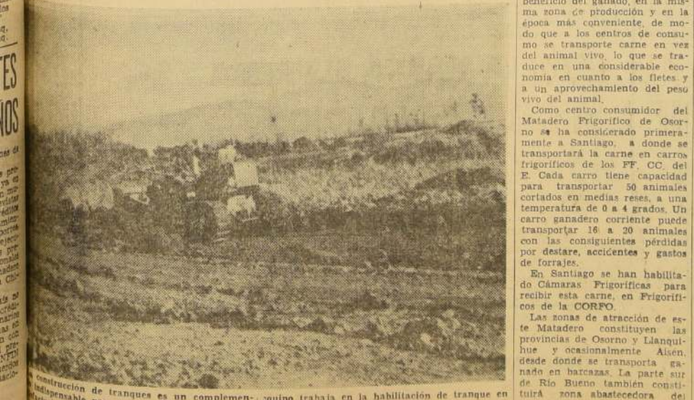
La construcción de tranques es un complemento indispensable para asegurar rendimientos satisfactorios en la agricultura, principalmente en las regiones de secano. En el grabado, un equipo trabaja en la habilitación de tranque en el campo experimental de Ovalle de Tuqui, en la zona de Ovalle.
