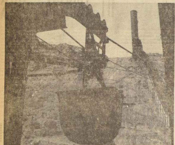
Los capachos cargados de concentrado de cobre llegan a la fundición de Calientes, después de un viaje de 12 kilómetros por andarives desde Sewell.
