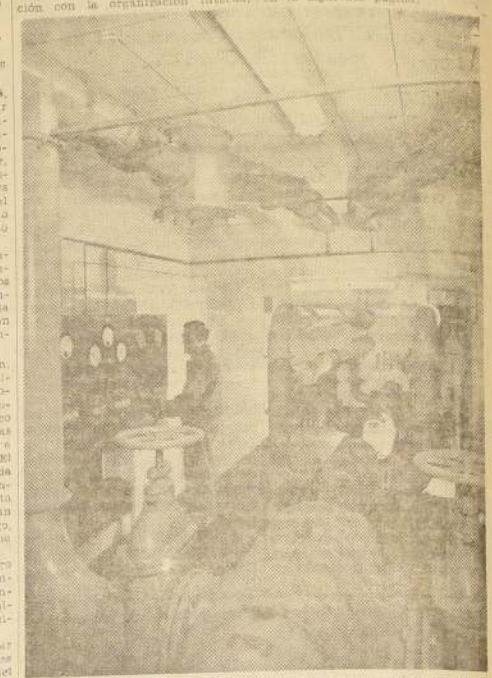
Notable es el sistema automático de correos neumáticos que funciona en el edificio principal del Banco del Estado. El grabado da una impresión de la central de este servicio que cuenta con 36 estaciones internas.
