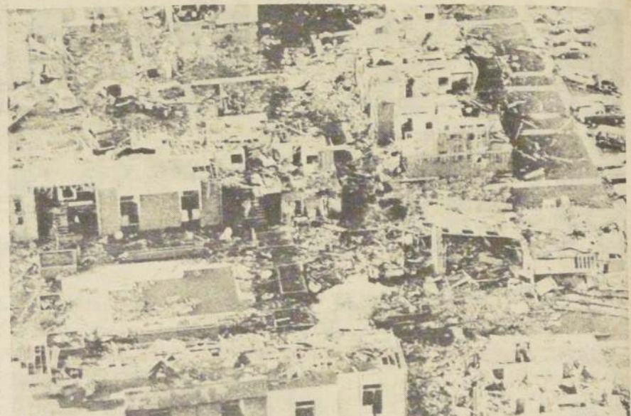
WICHITA FALLS, TEXAS.— Varias zonas residenciales de Wichita Falls quedaron destruidas por los tornados que se desencadenaron en Texas y Oklahoma. La escena es elocuente de los efectos de la devastación (RADIOFOTO UPI, VIA UNIFAX).
