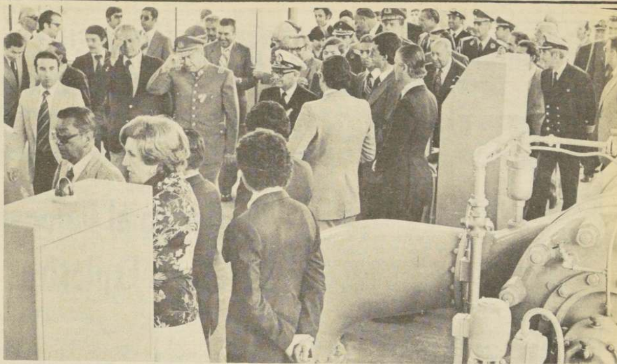
EL PRESIDENTE DE la República, General Augusto Pinochet Ugarte, recorre junto al Intendente de la V Región, Contralmirante Arturo Troncoso Daroch, y al Ministro de Obras Públicas, Hugo León Puelma, la tercera impulsión de agua potable de esa zona, que permitirá aumentar en casi un 50% la cantidad de este producto y que abastecerá a Valparaíso y Viña del Mar.
