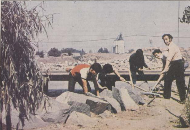
TRABAJOS EN RIBERAS DEL MAPOCHO
