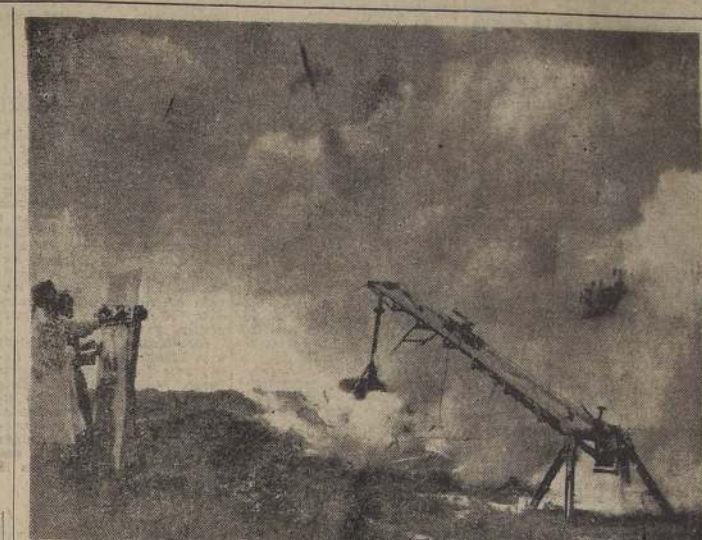
COHETE TRANSPORTADOR DE CORRESPONDENCIA. — BREMEN, Alemania. — El primer cohete alemán de la postguerra cruza rumbo a salir disparado de su rampa de lanzamiento, cerca de Bremen. Esta es la primera de cinco pruebas proyectadas con esta clase de bombas cohetes destinadas a transportar correspondencia. En el tablero conmutador está el profesor Albert Puellenberg, jefe del grupo de alemanes peritos en cohetes voladores, quienes en tiempo de Hitler fueron los creadores de las bombas V-1 y V-2. Ahora han diseñado este cohete-correo. Inspectores de la Junta de Seguridad Militar Aliada son los que están realizando estos experimentos en Alemania. — (Foto UNITED PRESS).
