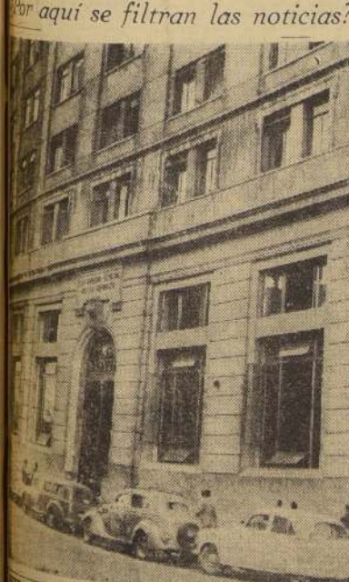
En el frente del edificio que ocupa la Contraloría General de la República.
