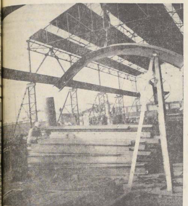
foto nos muestra las grandes vigas de acero y los arcos del mismo material se utilizan en la construcción del túnel que se está construyendo en Sewell como importante etapa del Programa de Expansión de la Sociedad Minera "El Teniente". SOCOMETAL, una de las grandes industrias metalúrgicas chilenas, es quien está llevando a cabo esta importante labor, demostrando el aporte de la industria nacional a dicho Programa.
