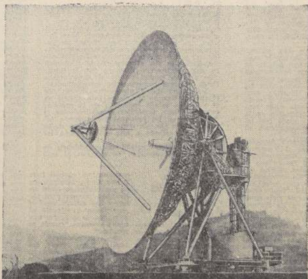
Estación Terrestre de ENTEL, ubicada en Longovilo, en una zona de silencio cósmico y terrestre, a 40 kilómetros al sur de Melipilla y a 120 kilómetros de Santiago. Destaca su gigantesca antena parabólica de 30 metros de diámetro y de más de 200 toneladas de peso.
