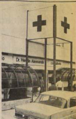
Fachada del nuevo Consultorio "Doctor Hernán Alessandri", ubicado en calle Jesuitas 857.
