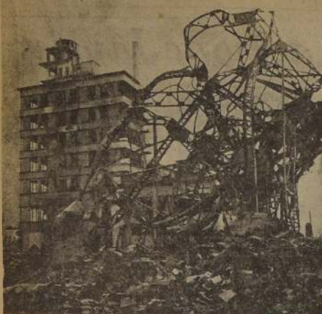
El edificio de la Prensa Chugoku, en la calle principal de Hiroshima, poco después de la explosión atómica. Este edificio soportó la enorme fuerza de la explosión, pero su interior quedó totalmente destruido. — (Foto ACME exclusiva).
