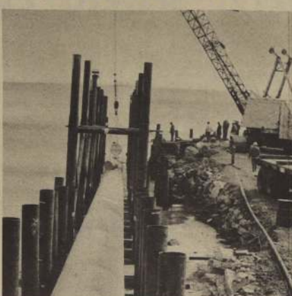
ESTA ES UNA de las cañerías, de 42 pulgadas de diámetro, que se introdujo 2.600 metros en el mar hasta llegar a la monoboya, donde se descargará el petróleo crudo de barcos de hasta 200.000 toneladas en Quintero.
