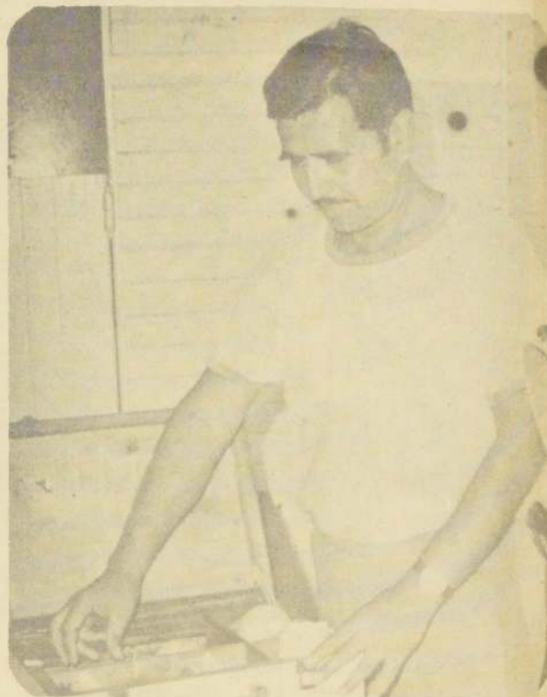
Una sala de masajes que cuenta con aparatos de ultratermia y un completo botiquín para primeros auxilios ha sido habilitada dentro del recinto del Estadio INSA.
