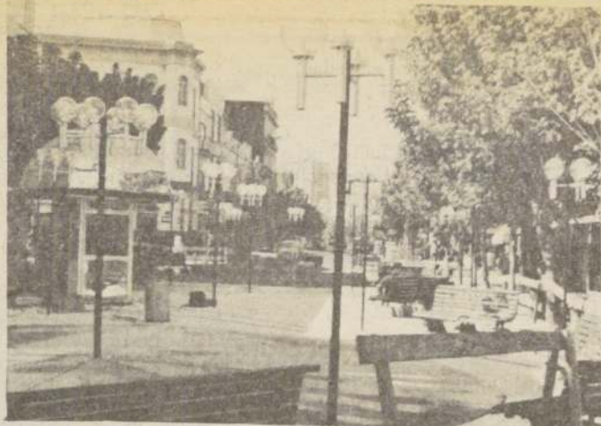
Dos millones setecientos mil pesos invirtieron los comerciantes de calle Victoria en construir este paseo peatonal, que se inaugurará hoy.
