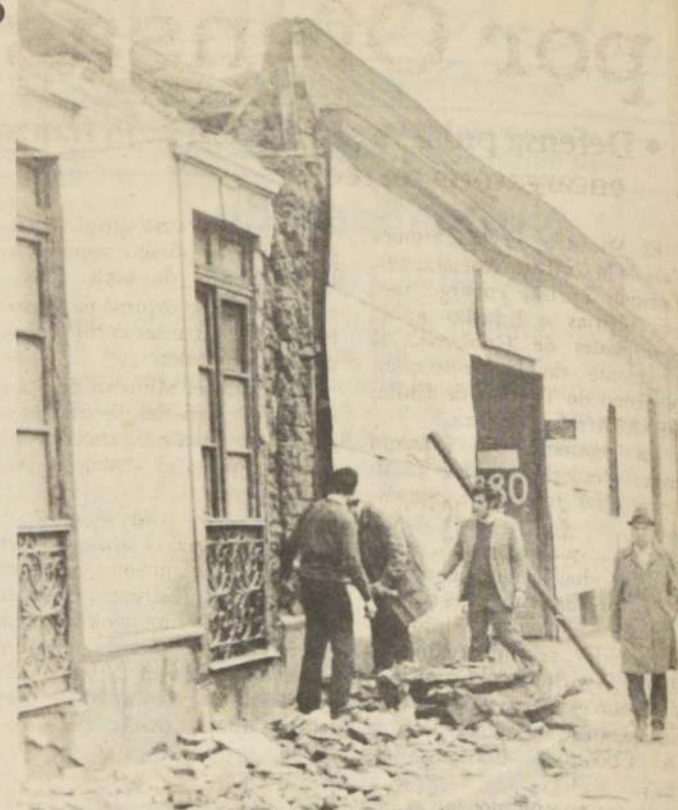
Casas como las que aparecen en la foto, prácticamente a punto de derrumbarse, se arriendan poniendo en serio peligro la vida de quienes las ocupan.
