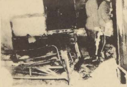
MARIETA, ESTADOS UNIDOS.- Bomberos aún con extinguidores en la mano, recorren las carbonizadas dependencias del Hospital de Ancianos destruido por un incendio. 21 personas murieron en el siniestro. En el otro grabado, rescate de una de las víctimas (RADIOFOTO UPI).
