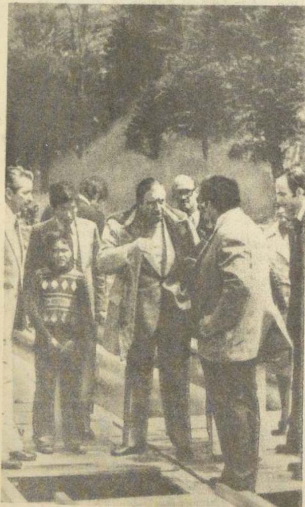
El Mandatario, vistiendo gruesa parka para neutralizar las bajas temperaturas de la zona austral, recorrió caminos y obras públicas, pidiendo cuenta a cada funcionario del trabajo que está efectuando. (Radiofoto DIG)
