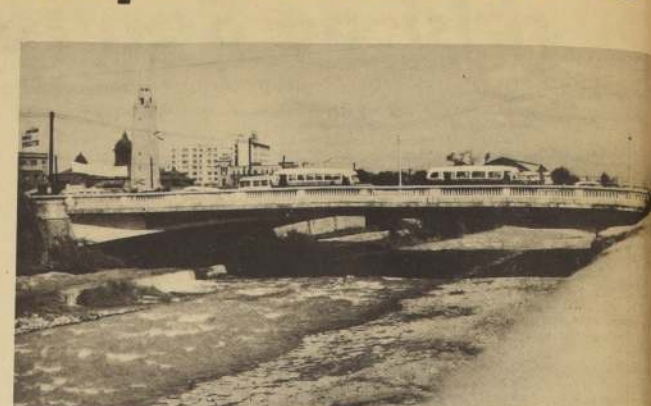
NUEVOS TRABAJOS. — Obras Públicas deciden realizar importantes obras de las aguas del río Mapocho. En el grabado, el viejo río, en el sector del puente Recoleta.
