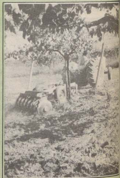
Como los arados de disco han sido diseñados para reducir el rozamiento, su trabajo es más efectivo en suelos pedregosos, pesados, secos y muy duros.
