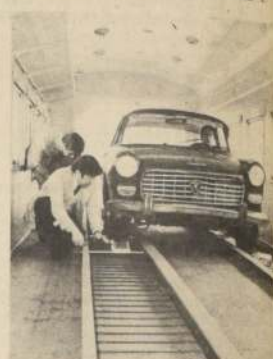
Con sistemas especiales de anclaje y rejillas en las ventanas cuentan los siete transportadores, que aumentarán a nueve en los próximos días, destinados a realizar el transporte de automóviles.
