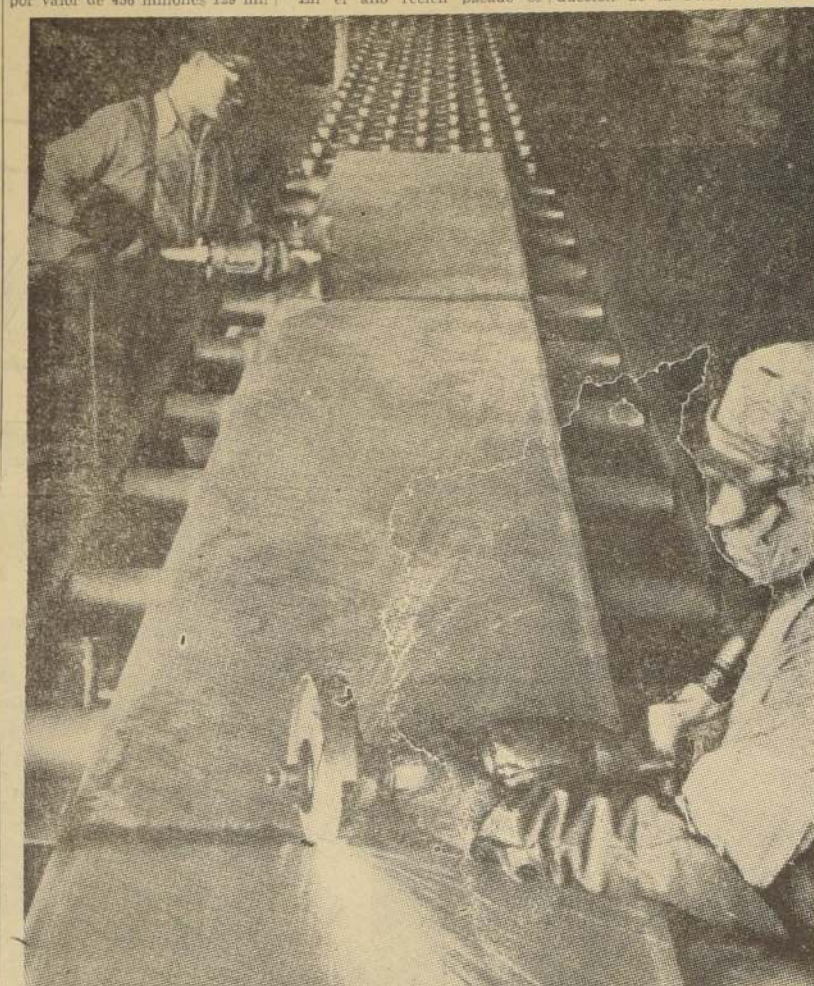
FABRICACION DE CASERIAS. —Estas planchas de acero de Huachipato se convertirán en cañerías para agua potable. Ya han sido soldadas y los operarios que se divisan en el grabado, con sus equipos de protección, pasan el esmeril eléctrico a las soldaduras, para evitar las irregularidades de superficie.
