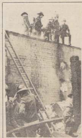
Este era el galpón principal, que como se puede apreciar en la fotografía quedó convertido en escombros. Voluntarios extinguieron las llamas que amenazaron a varias viviendas ubicadas en las cercanías.
