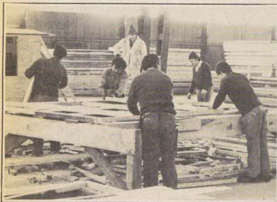
Junto con cambiar del PEM al POJH, los beneficiados integrarán cuadrillas de mayor productividad en trabajos de infraestructura definitiva: construcción de casas y sedes sociales, veredas, obras de ingeniería y otros.
