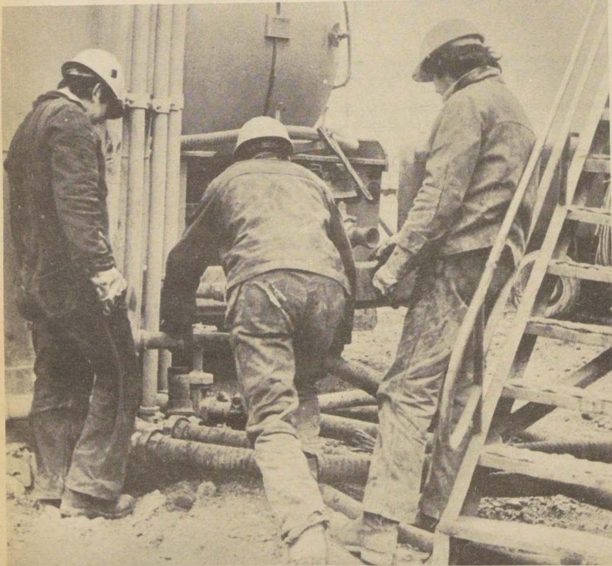
LA INSTALACION de un equipo de perforación se hace en un día. En la foto, trabajadores de ENAP
