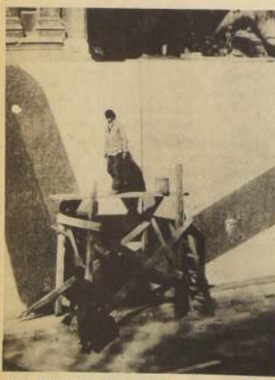
LA TERMINACION de los muros del Paso Bajo Nivel. Decoración audaz y moderna que da la sensación de fluidez y movimiento. Ondas azules sobre fondo blanco.
