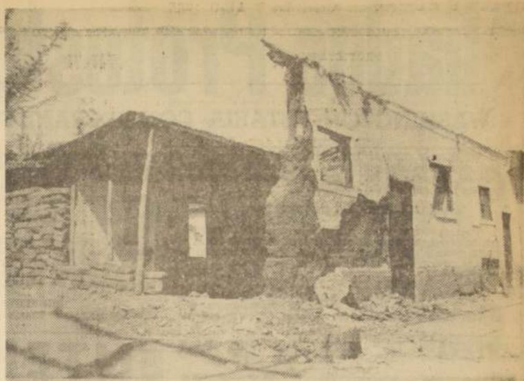
LA CRUZ. — CASAS DAÑADAS. — La fachada quedó en pie, pero el derrumbe de una pared lateral dejó al descubierto la destrucción total del inmueble signado con el número 236, de 21 de Mayo, en La Cruz. Así está casi todo el pueblo.
