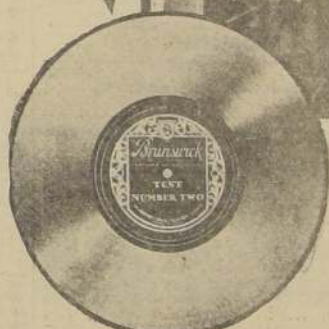
7.—DISCO NUMERO 2: Reproducción de la misma transmisión recibida por radio con un receptor Brunswick y grabada de éste. Comparados ambos discos, resultaron completamente iguales.
