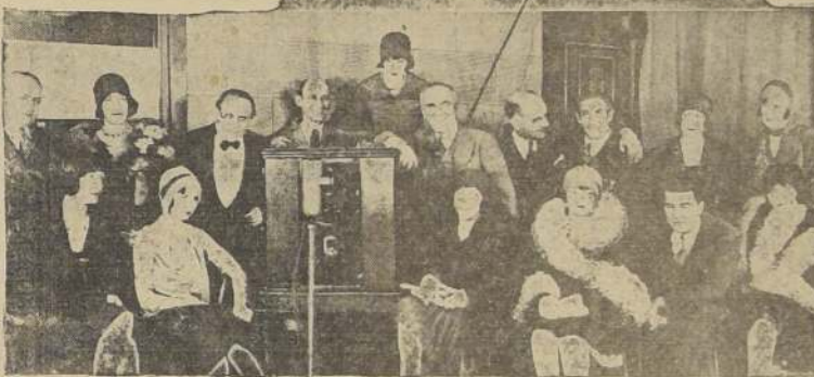
5.—Un micrófono colocado frente al receptor Brunswick recoge la música de éste y la envía, a su vez, al laboratorio Brunswick, en donde se imprime otro disco.
