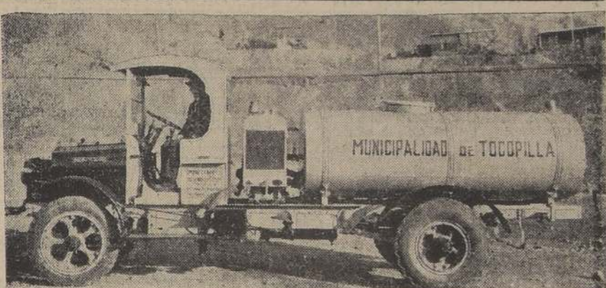
Tanque Regador de 3,000 litros, montado en chasis Brockway, modelo K de 3 tons. Se desempeña en incendios como Bomba de primera calidad
