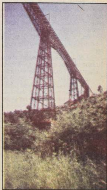
Esta es parte de la imponente estructura de acero del viaducto ferroviario del Malleco. Las piezas fueron construidas en Francia.
