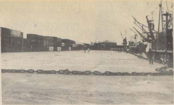
Emporchi ha dado prioridad y ha efectuado fuertes inversiones en la habilitación de áreas pavimentadas para el acopio y movimiento de contenedores, no sólo en Valparaíso, sino en todos los puertos a su cargo.
