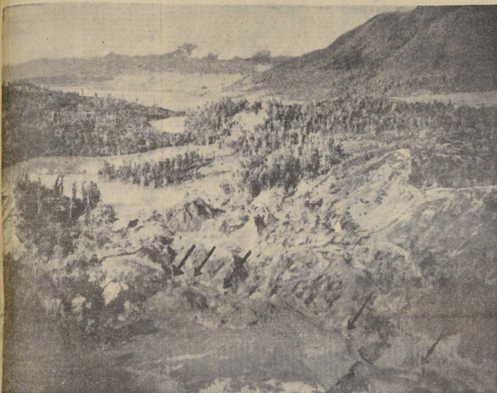
TRABAJOS EN EL LAGO.— Esta vista aérea del Grupo N.º 10 de la FACH permite apreciar los trabajos que se realizan para canalizar uno de los “tacos” que obstruyen el río San Pedro, desagüero del Riñihue. Al fondo puede verse el río, obstaculizado por los cerros que se desplomaron, y que aparecen en primer plano. Las flechas indican algunos de los bulldozers y otros elementos mecanizados que están en plena labor.
