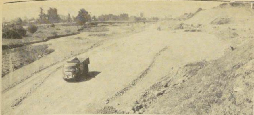
ASPECTO DEL TRAMO en construcción de la Costanera Norte del Mapocho, entre los puentes Mapocho y Lo Saldes.
