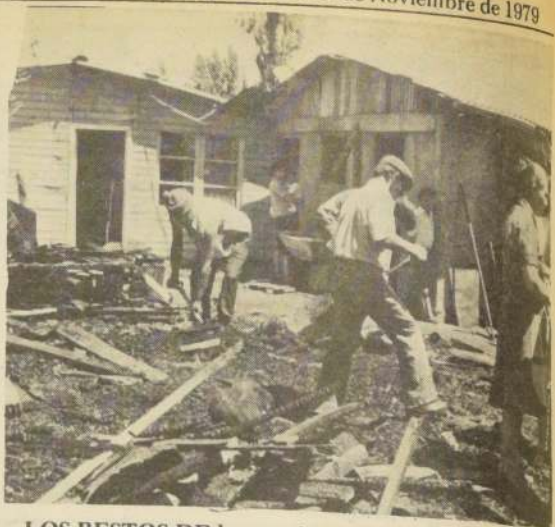
LOS RESTOS DE lo que fue el templo evangélico de la Pobl. La Quebrada. Al costado derecho, Luz Cea, la propietaria del inmueble, le cuenta a El Cronista la posible existencia de un pirómano.
