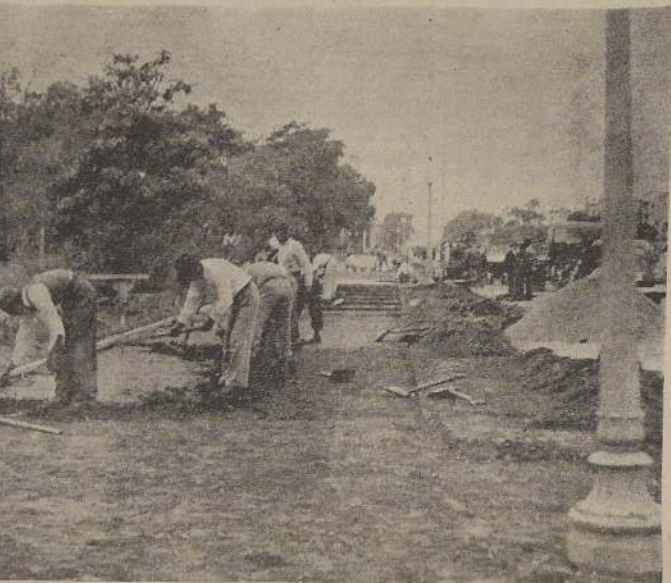
Aspecto de la labor de construcción de veredas perimetrales en el Parque Avellaneda. También se colocaron bancos de hormigón, construidos en los talleres de la Dirección de Paseos Públicos. Entre la vereda y cordón, irá un cantero de césped.
