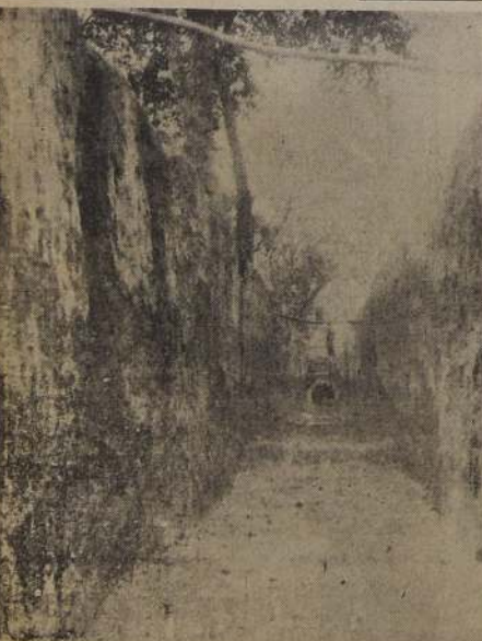
EXCAVACION Y COLOCACION DE CASERIAS en calle Corrientes a la altura de Paso de los Andes. Los caños de hormigón, de un metro de diámetro, son construidos en los talleres del Departamento de Obras Públicas, así como los moldes para su fabricación hechos enteramente con chapa.
