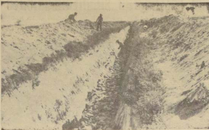
Kilómetros de trincheras ha excavado la Corporación de la Reforma Agraria, en el valle del Lluta, para drenar los terrenos pantanosos, donde sólo crecía la totora, y convertirlos en aptos para el cultivo. La zanja se cubre con grandes piedras y se vuelve a taponar. Por ella se escurre el agua, que no es aprovechada después en los cultivos, por ser salobre. (Foto de Carmen Merino.)
