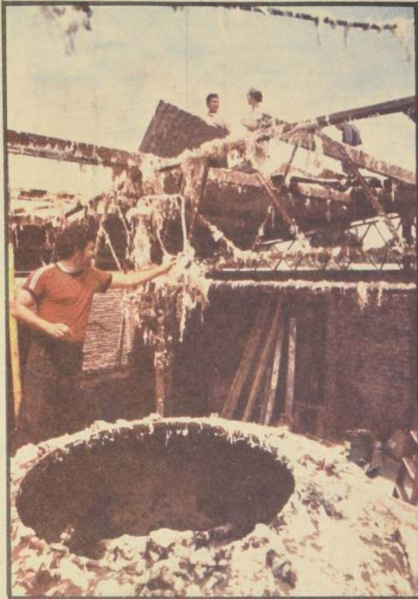
La explosión de la caldera de una Planta de Algodón provocó alarma y cuantiosos daños tanto en la industria como en doce casas vecinas, en calle Dresde. El accidente evidenció falta de medidas de seguridad, pues tendría su origen en una presión desmedida.
