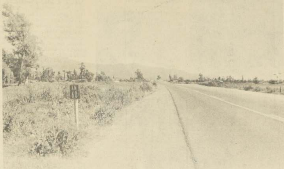
Con un nuevo acceso a Quillota se contará próximamente para cuya construcción se han destinado diez millones de pesos. "El Trébol" estará ubicado a la altura del kilómetro 60 del Camino Internacional, que muestra la foto.
