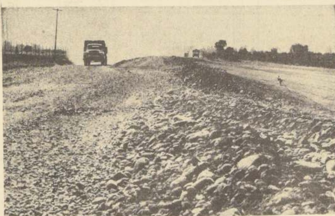
NUEVO CAMINO A SAN ANTONIO.— Una nueva carretera de dos pistas de alta velocidad, que acortará en varios kilómetros el camino a San Antonio, se encuentra construyendo la Dirección de Vialidad en el tramo comprendido entre El Paico y Padre Hurtado. Las pistas tienen una amplitud de siete metros, totalmente cerrada, especialmente adaptada a altas velocidades. Los caminos transversales a la nueva carretera pasarán bajo nivel y la línea del ferrocarril lo hará por encima de ella. Las obras estarán totalmente terminadas a principios de 1970.
