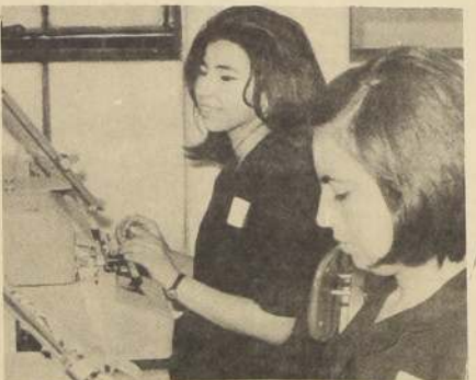
MEDIANTE moderno sistema electrónico se compone el diario LA NACIÓN, en el grabado, Cristina Muñoz y Fronda Carvallo. Trabajan en Teletypesetter "Fairchild" TTS.
