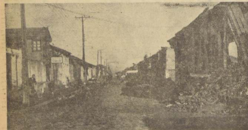
LA CALLE OROMPELO. — Así quedó la calle Orompello, del barrio Plaza Condell, en Concepción. En primer plano, se advierte un viejo edificio derrumbado. Casi siempre los frentes cayeron hacia el lado exterior, librando las plantas interiores con daños menores.
