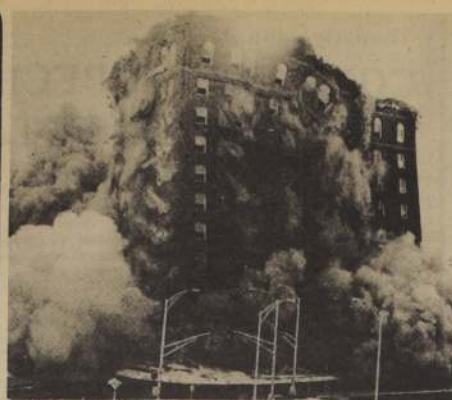
WINSTON (SALEM).—Los doce pisos del Hotel Robert E Lee cayeron, luego de las explosiones ordenadas para demoler el viejo edificio. La demolición tomó diez segundos, para abrir paso a la construcción de un nuevo hotel.
