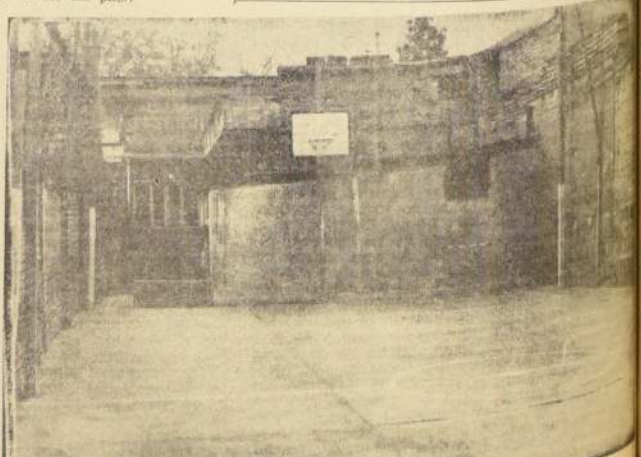
La foto muestra un aspecto del gimnasio que la "YMCA" tiene en la ciudad de San Bernardo, y que será remodelado para dar mayores comodidades a los socios y amigos de la institución en esa ciudad.
