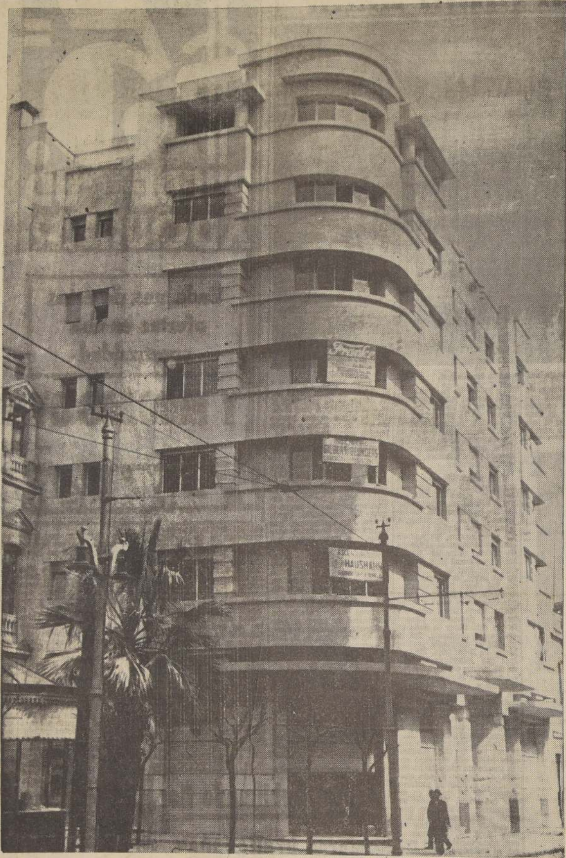
Vista en conjunto de esta moderna construcción
