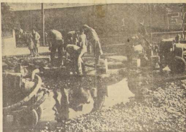
Una cuadrilla de cinco obreros de la Empresa de Agua Potable de Santiago trabajaba ayer para descubrir la cañería matriz de Avenida Balmaceda esquina Bulnes, la cual presenta una filtración. Esto ha obligado a cortar el agua en el sector, aunque se tomaron las medidas para que tan vital elemento no falte al Hospital San Juan de Dios. En el grabado, la cuadrilla en plena labor.
