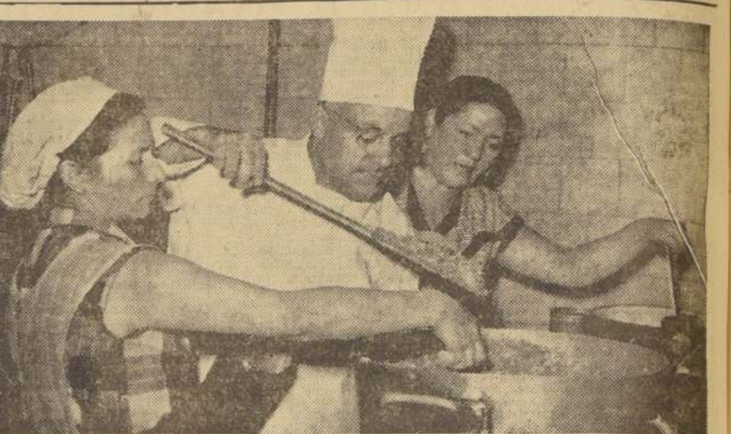
Don Carlos Mervilles vigila personalmente la condimentación del "Curanto".
