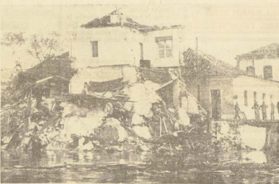
GUARATUBA, BRASIL.— El misterioso avance de las aguas sobre esta población causó los destrozos que muestra la fotografía. Numerosos edificios desaparecieron hasta sus cimientos a causa del inusual nivel que alcanzaron las aguas del Océano Atlántico que baña el sector donde se produjo el fenómeno. No hubo víctimas, pero los daños en las construcciones fueron cuantiosos. (Fotografía UPI.)
