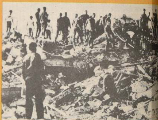
BEIRUT. — Cuadrillas de rescate trabajan en las ruinas de un edificio de diez pisos que fue destruido en un atentado. Un contingente de 150 soldados franceses se encontraban dentro del edificio. La foto muestra el momento en que se remueven los escombros para ubicar los cadáveres de los soldados. (Radiofoto AP).
