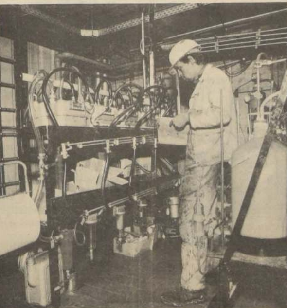
En el Instituto de Investigación Minera de Essen se fabrica gasolina a partir del carbón. La experiencia está limitada al ámbito del laboratorio. Se trata de perfeccionar viejos procedimientos, para hacerlos más baratos, menos contaminantes y más productivos. Está en construcción una gran planta de ensayo.
