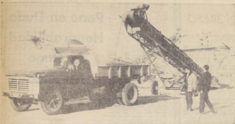
Una máquina especial, que aparece funcionando en el grabado, entrega el material que se usa para la pavimentación de la pista de aterrizaje del aeródromo de Rancagua. También aparecen el presidente del Club Aéreo de Rancagua, Alejandro Napoleoni, y un representante de la firma que tiene a su cargo la obra, mientras observan la carga de un camión que enseguida llevará el material a la pista.
