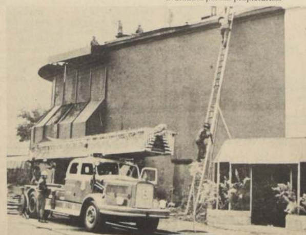
Engañoso aspecto del club "Regine's" luego del incendio del 13 de febrero pasado. Sólo quedó en pie la fachada exterior. Los pisos interiores del inmueble resultaron completamente quemados.
