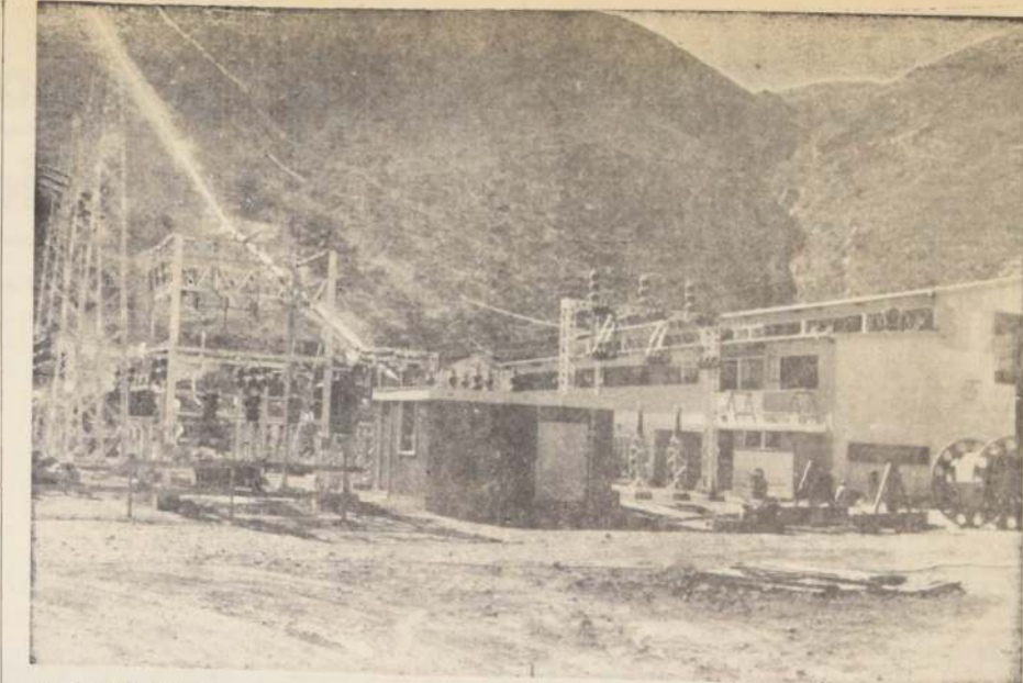
La Central Hidroeléctrica de Chapiquiña, cuya energía ya está abasteciendo a Arica, y que próximamente llegará mediante cables de alta tensión y subestaciones eléctricas hasta Iquique, promoviendo el desarrollo industrial y minero de la zona, y agrícola en algunos valles y quebradas.
