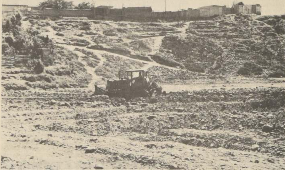
En estos días se están efectuando trabajos de emparejamiento de terreno, en la primera etapa del nuevo complejo deportivo del Parque Coll, en La Serena.
