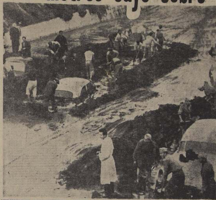
AUTOMOVILES EMPANTANADOS — Cuatro vehículos quedaron empantanados en una avalancha de lodo que arrastró el agua de un sifón hidráulico, rota en el camino de Viña del Mar a Concón. Un cerro de 25 metros de altura fue arrastrado por las aguas hacia la vía caminera. Después de varias horas de trabajo, los automóviles fueron sacados del fango. El gravado nos da una idea de la dura tarea. Los vehículos quedaron totalmente destruidos.
