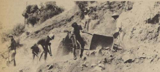
CON PALAS, CHUZOS Y CARRETIILLAS DE MANO los voluntarios de Angostura dieron el impulso fundamental a la construcción de una variante del tendido del ferrocarril en ese lugar. Su esfuerzo fue altamente valorado por los trabajadores de la Empresa de Ferrocarriles del Estado.
